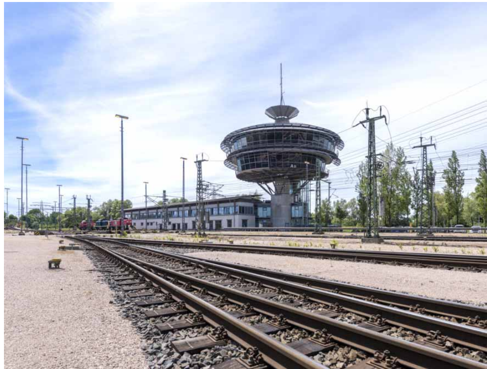
Das Stellwerk „Alte Süderelbe“ glänzt mit seinem besonderen Design. Es steht heute unter Denkmalschutz.
