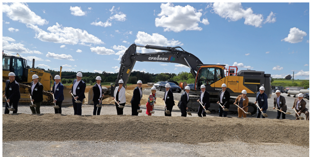
Spatenstich für das künftige Container-Terminal.
